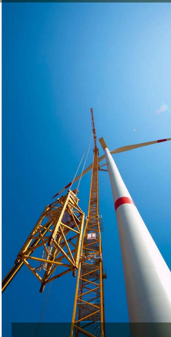
Turmstücke lassen den Kletterkran gemeinsam mit der Windenergieanlage in schwindelerregende Höhen wachsen.
